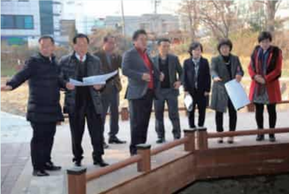
석수동 삼막교 하부 도로공사현장 확인(2016)
