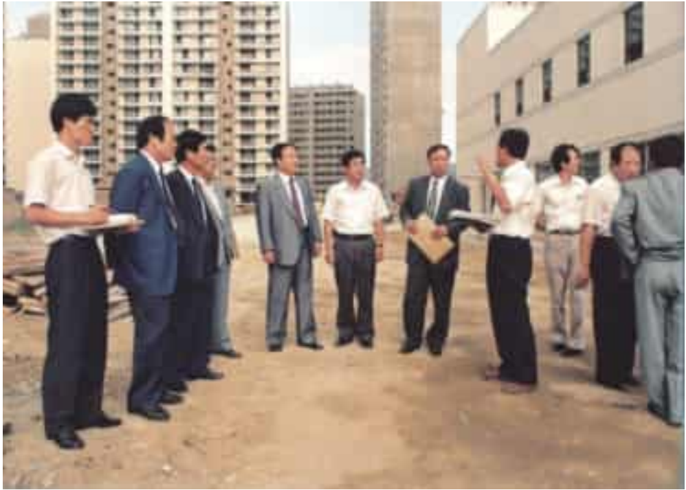
평촌신도시 공사 현장방문(1993)
