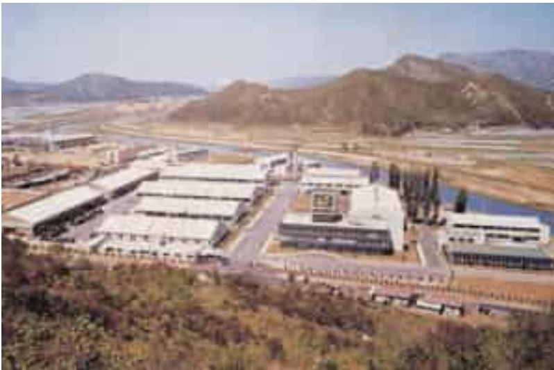
노루표페인트 안양공장(1976, 『노루70년사』)
